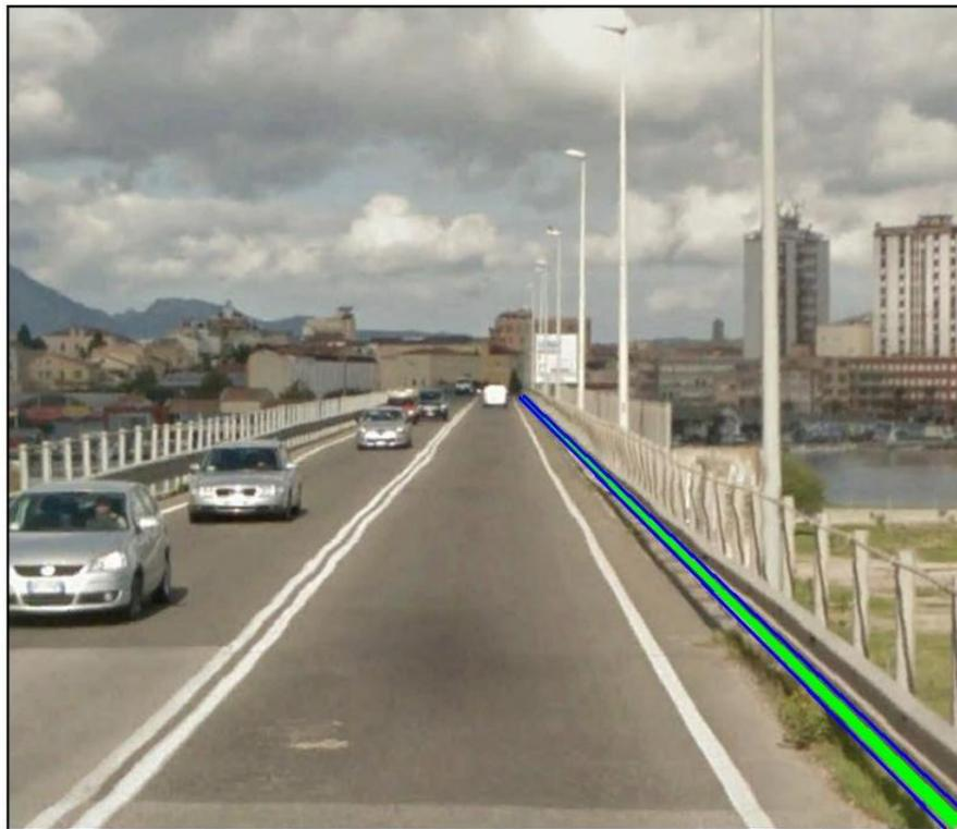
Via Principe Umberto - Condotta su impalcato zancata al di sotto del marciapiede con Contrutubo in Acciaio
